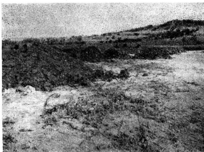
9. Automobily navezená ornice na povrchu urovnané rekultivované výsypky v Pařídlech u Mostu.
