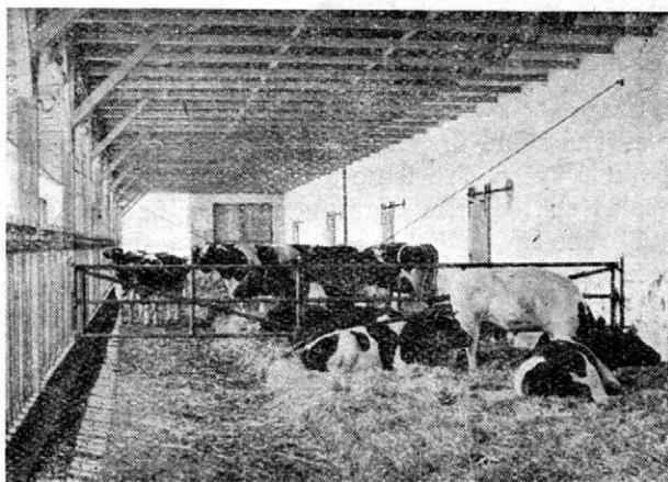
4. Zpevněné krmíště a betonovým obrubníkem oddělená lehárna v otevřené stáji statku Dornburg
