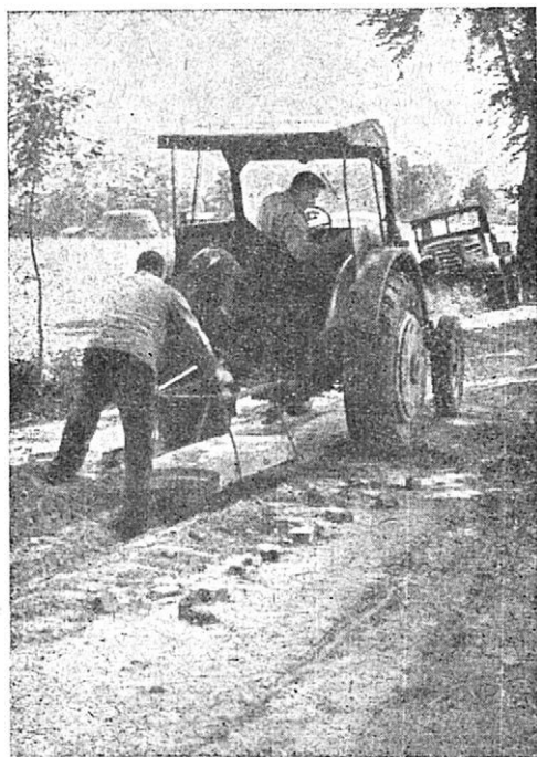
3. Ukládání prefabrikovaného dílce do rýhy
