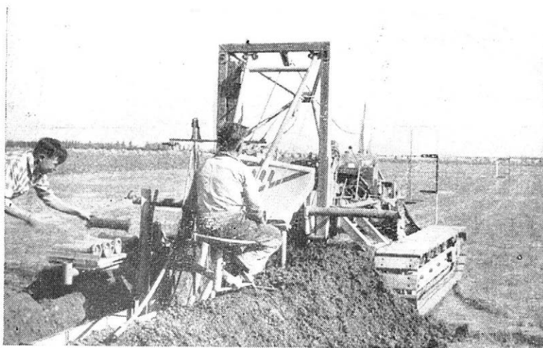
14. Drenážní rýhovač Van den Ende (Holandsko) při práci
