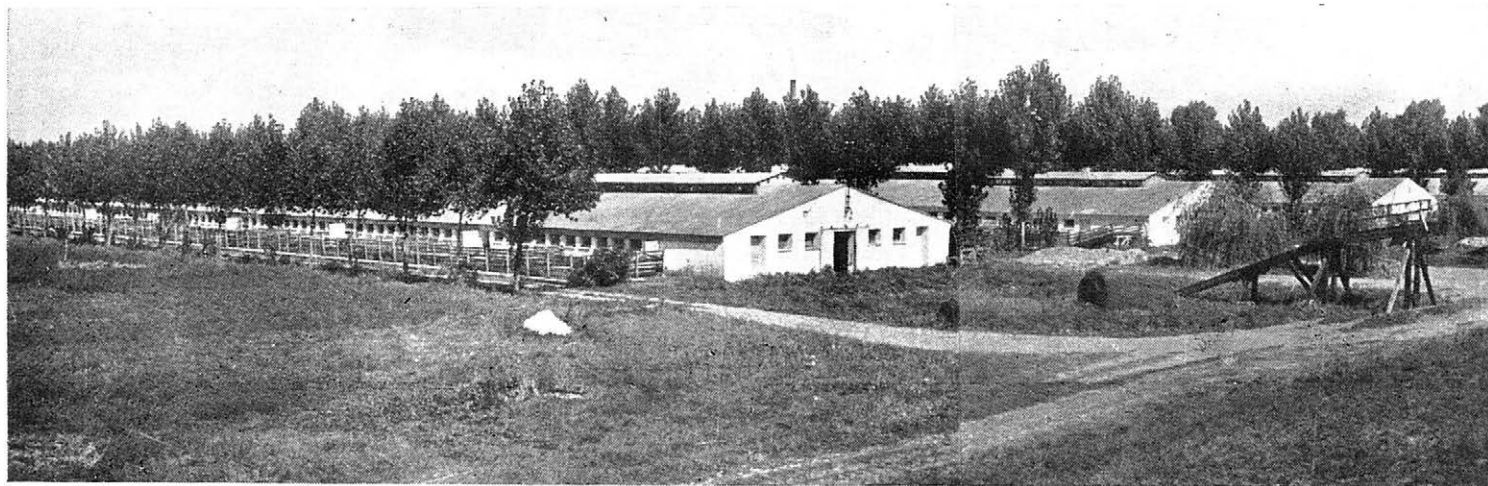
1. Velkovýkrmnna Smiřice n. L. Pohled na východní polovinu pavilónů ze strany ramp na odvážení výkalů
