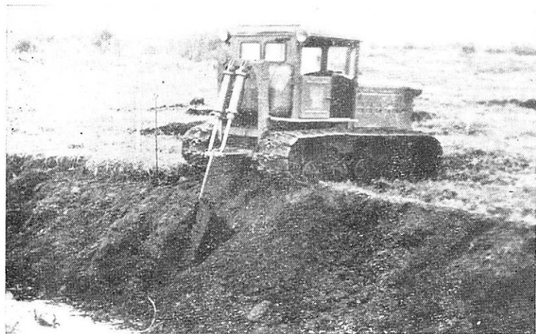
17. Stroj na krtčí drenáž DKG-55 (SSSR)
