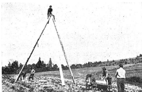
3. Stavba kozovej podpery (foto inž. Roško)
