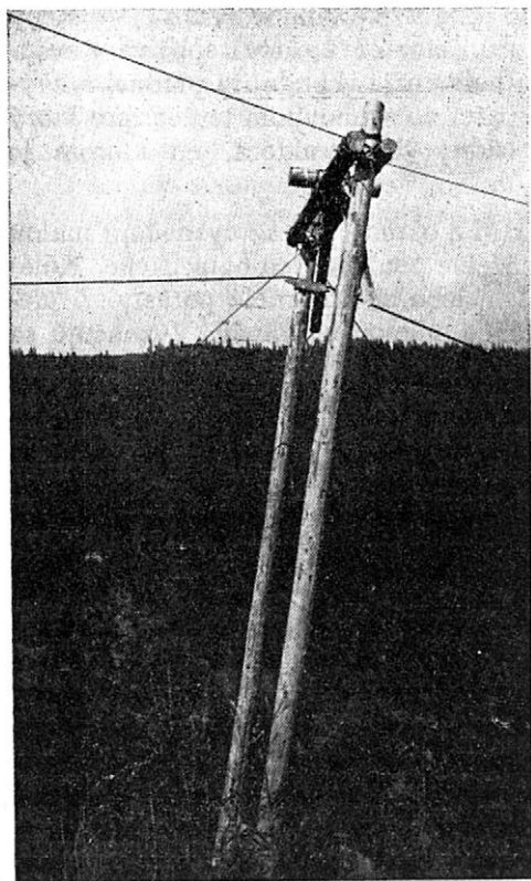
1. Jednoduchá drevená „A“ podpera. Princíp konštrukcie pre ťažšie prípady (foto inž. Gašparík)
