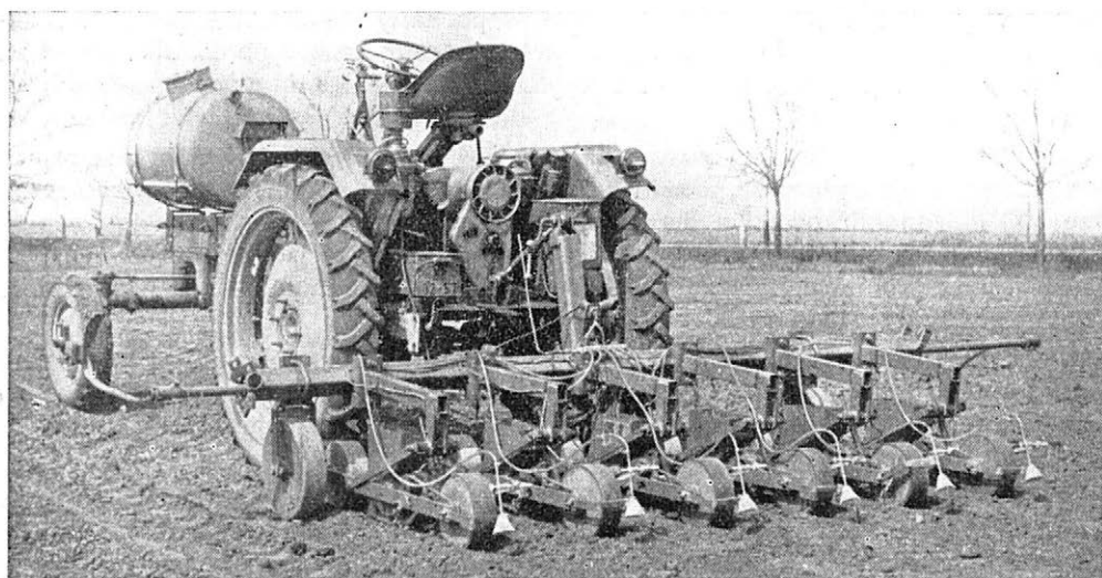
1. Šestiřádkový stroj pro přesný výsev s adaptérem pro pásový postřik herbicidů. Nádrž na roztok a čerpadlo jsou umístěny na páteřovém nosníku traktoru
