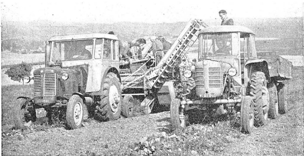
5. Sklizeň brambor sklízěčem E 675 z řádků připravených řádkovačem 2 VBZ
