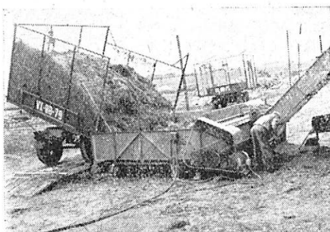
3. Mechanizovaná linka plnění skladu suchou pící
