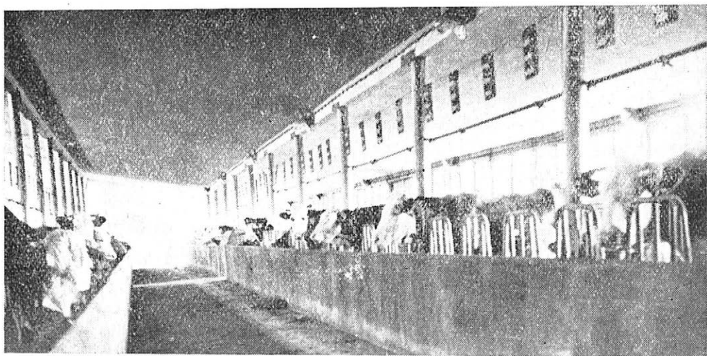
7. Krmná chodba určená pro projíždění samozakládacím vozem
