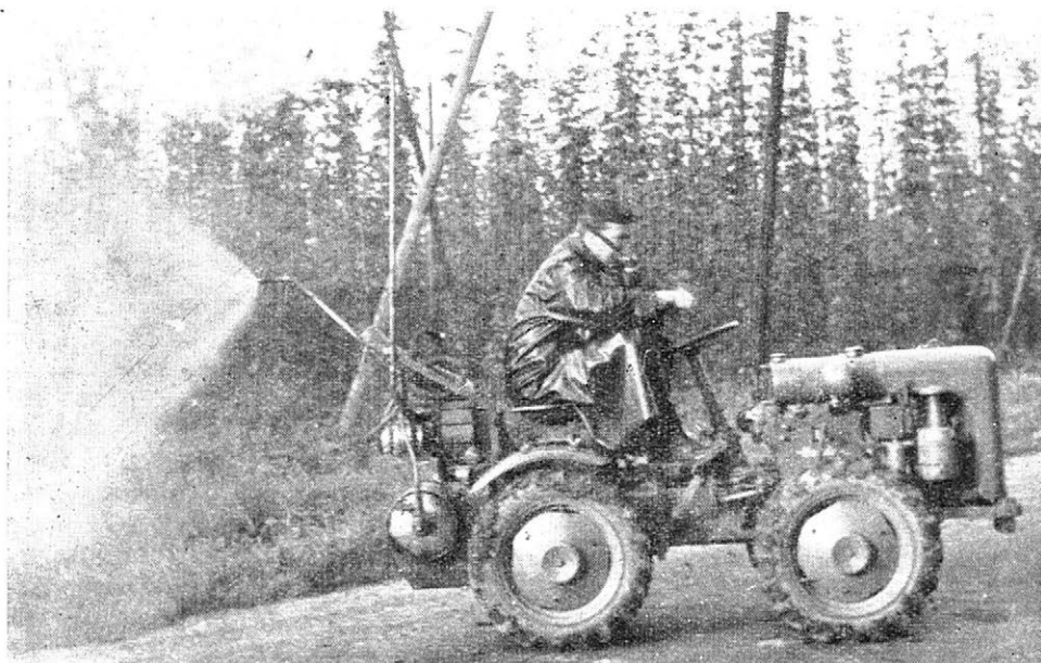
5. Funkční model se dvěma zmlžovacími tryskami, umístěnými nad sebou (foto C. Mejkal).
