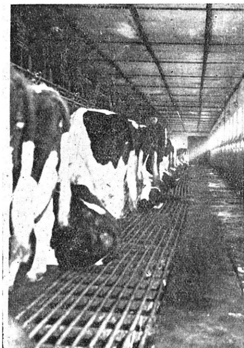
4. Celkový pohled do bezstelivové stáje. Pro zhotovení kališkových roštů bylo použito tyčí z PVC
