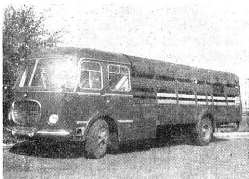
5. Převážník prasat na podvozku Š 706 R. Kapacita 60 kusů (foto Strouhal)
