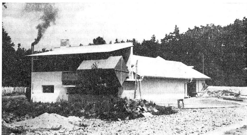
6. Celkový pohled na bramborárnu
