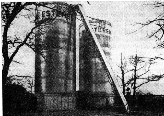
2. Plnění silážní věže Esterer mechanickým dopravníkem
