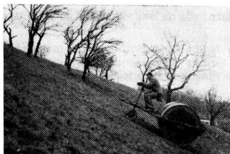
9. Lúčny valec upravený pre navijakovú trakciu. Svah 27^\circ na JRD Devín
