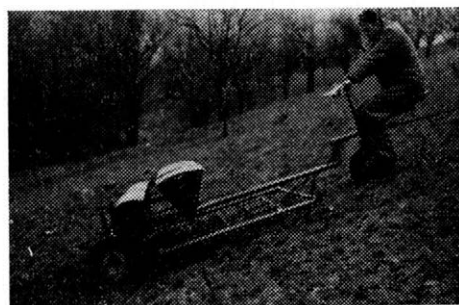
8. Navijakový podvozok s agregátom sejačky na trávnu, rozmetadla a brán. Svah 27^\circ (JRD Devín)
