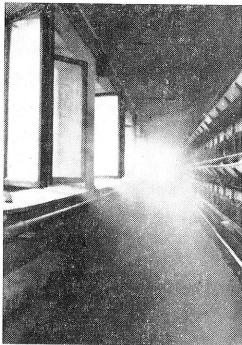
8. Ověřovací zkoušky po ročním provozu ventilačního systému v drůbežárně — proudění, rychlost a směr je otevřenými okny hrubě narušeno
