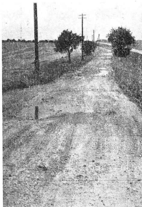
2. Část měřicího úseku na komunikaci II. třídy
