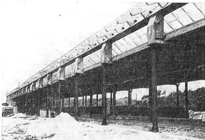
2. Pohľad na výstavbu dvojradovej stajne pre 100 ks dojníc s povalovým skladovacím priestorom
