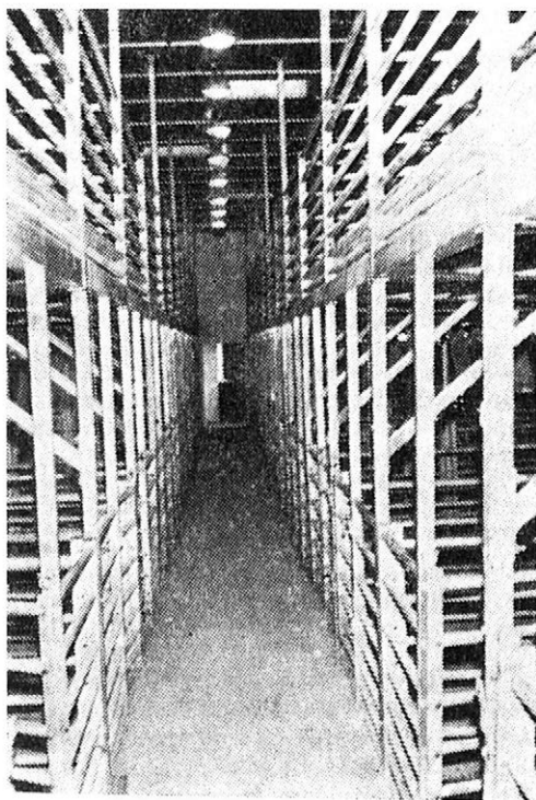
5. Výkrmna prasat s bateriemi kotců ve dvou podlažích a s dávkovým krmným PKS na podlahu kotců
