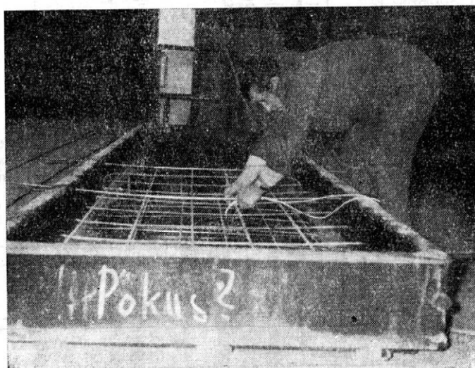
4. Vkladanie termočlánkov do konštrukcie pokusného stenového panelu z porobetónu PS 30-550 vo výrobní prefabrikátov
