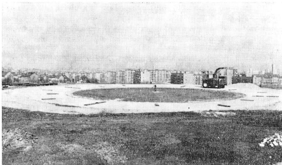
1. Celkový pohled na kruhovou dráhu VÚZS
