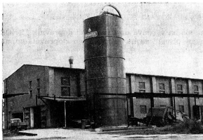
3. Celkový pohled na kontinuální linku — General view of the continual line
