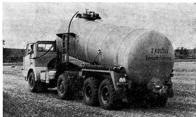
13. Automobilní fekální návěsová cisterna HLS 150.27 (funkční model) s tahačem Tatra 813 NTH — The HLS 150.27 faecal tank trailer (functional model) with the Tatra 813 NHT towing vehicle
