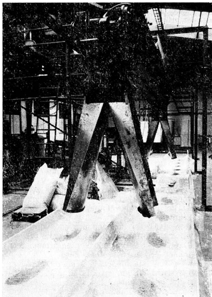
1. Celkový pohled na funkční model linky pro individuální dávkování jaderných krmiv ve vazných stájích v součinnosti s nadžlabovým dopravníkem PNL-500 (realizováno ve VÚZT) — A view of a prototype of the feed line for individual concentrate batching in stanchion byres in cooperation with a PNL-500 overhead conveyer (implemented in the Research Institute of Agricultural Engineering)
