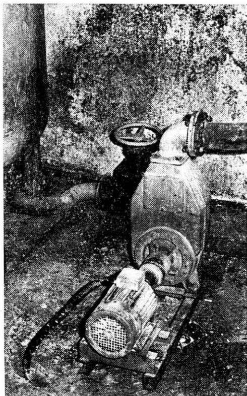
4. Dopravné čerpadlo typu 80-NFM-205 potrubnej linky na distribúciu tekutého krmiva — Type 80-NFM-205 pump in the pipeline system for the distribution of liquid feed
